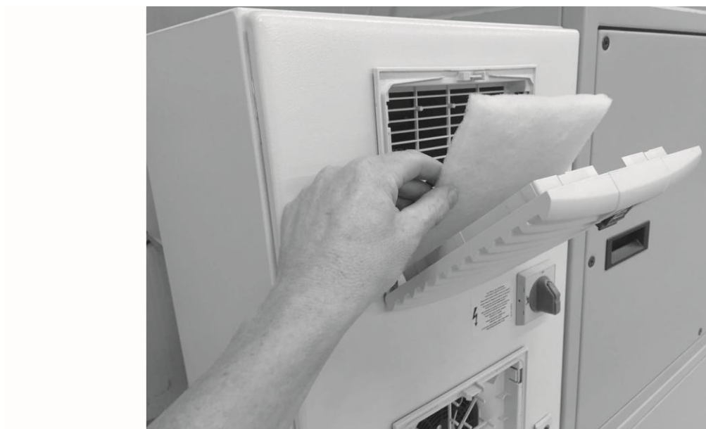
Fig. 39 : remplacement du filtre armoire de commande
